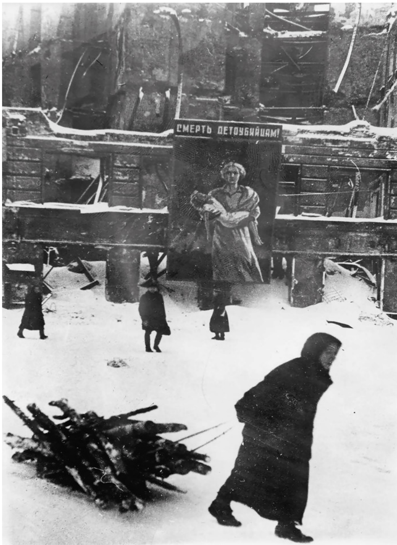
В.Г. Федосеев. Вид разрушенного дома на углу Лиговской и Разъезжей улиц. Ленинград, 1 марта 1943. Цифровая копия с бромсеребряного отпечатка. 12 × 18. ЦГАКФФД СПб. Ар 8643.
