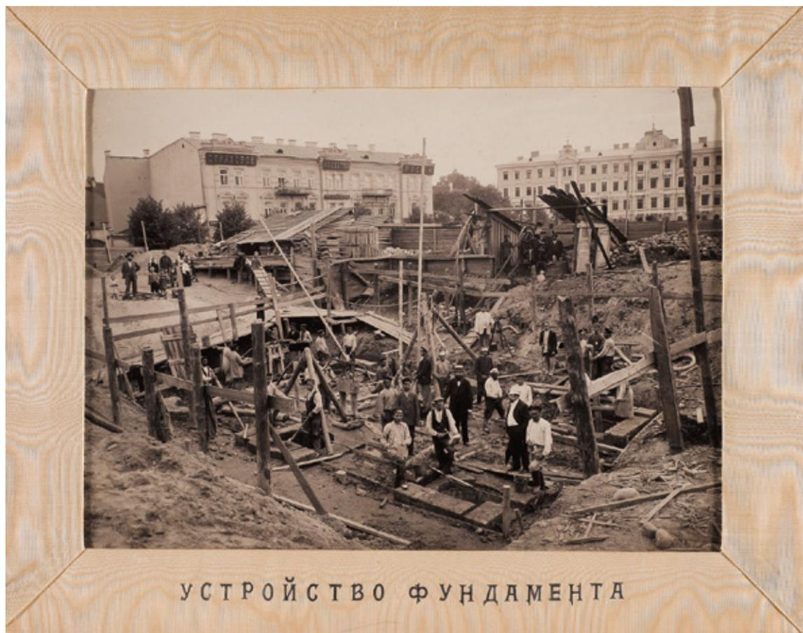
А.З. Циновец. Сооружение фундамента. Устройство опускных колодцев. Окончание работ. 1901 начало июля. Коллодионовый отпечаток; накладное паспарту. 19,0 × 26,1; паспарту: 26,6 × 33,8. ГГГ. ДЕК 377/ос-413/3
